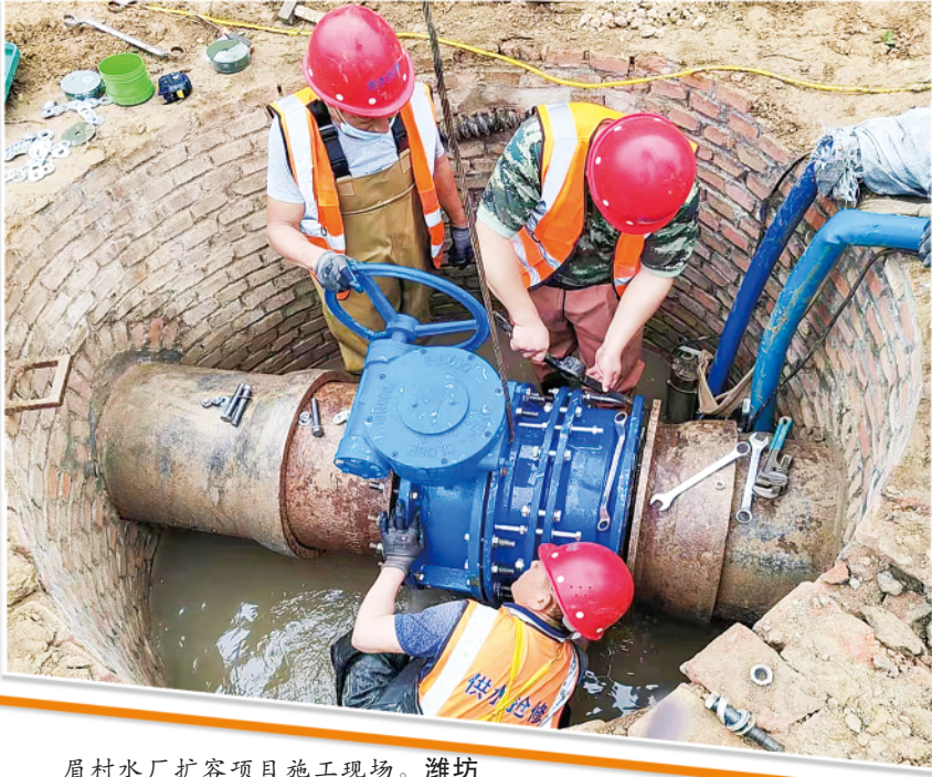
眉村水厂扩容项目施工现场。潍坊日报社全媒体记者 赵春晖 摄
