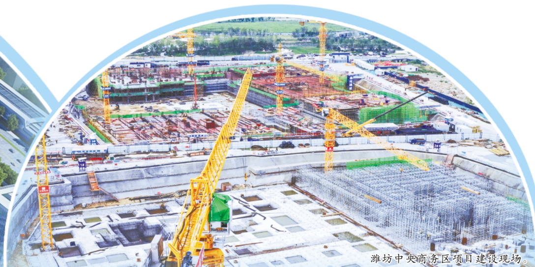
潍坊中央商务区项目建设现场。
