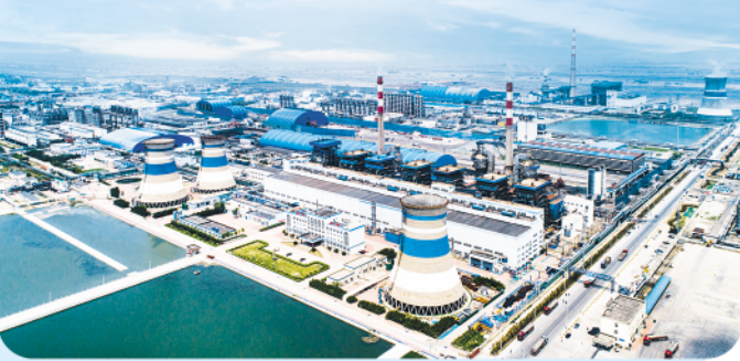
山东海化集团有限公司厂区。
