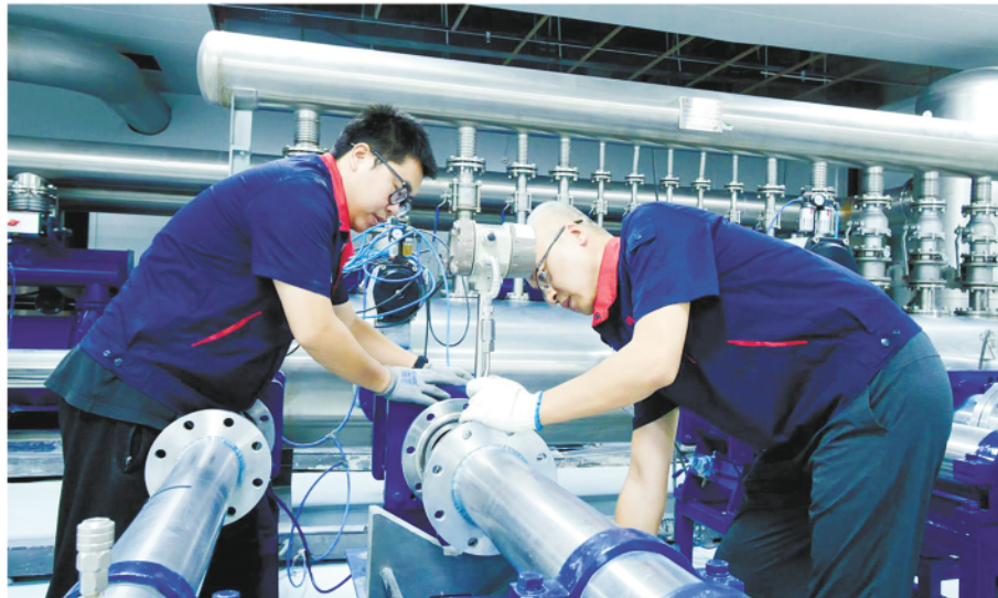
市计量技术研究院技术人员对大口径气体流量计进行检定。
