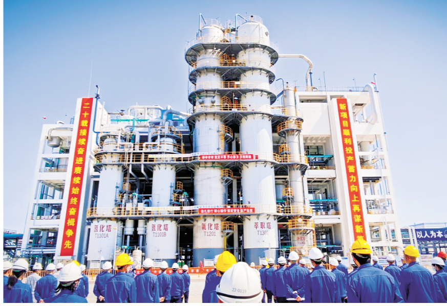
△山东海化氯碱树脂有限公司20万吨/年双氧水项目竣工。
