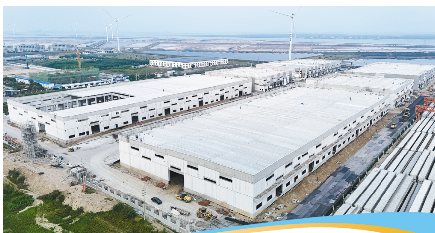
滨海区高端智慧供应链产业园项目建设现场。
