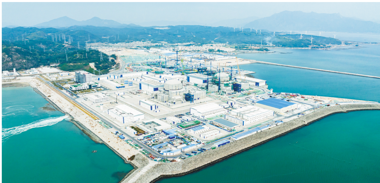
这是2025年1月1日拍摄的建设中的漳州核电站(无人机照片)。(新华社发)
