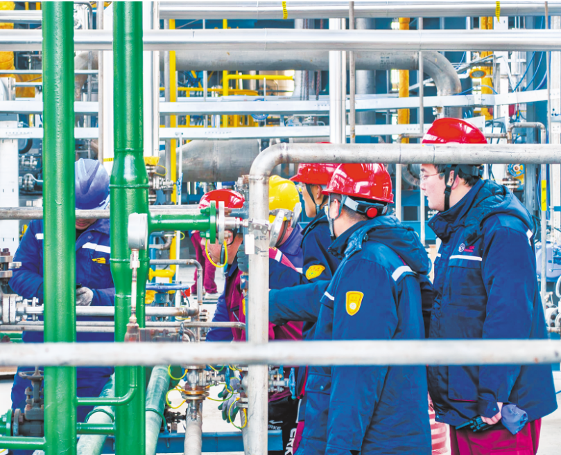
天辰新材料项目建设现场。
