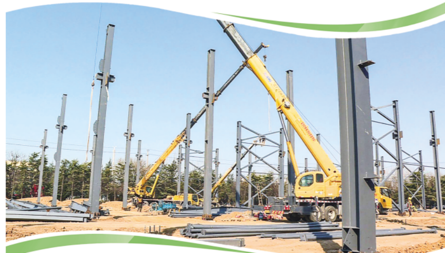
△潍坊励进塑料科技有限公司超高分子量聚乙烯纤维制品项目建设现场。
