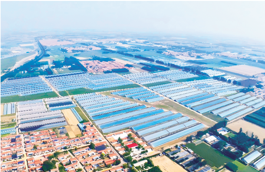
共富产业园航拍图。
