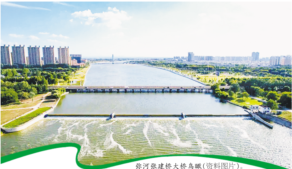
弥河张建桥大桥鸟瞰(资料图片)。
