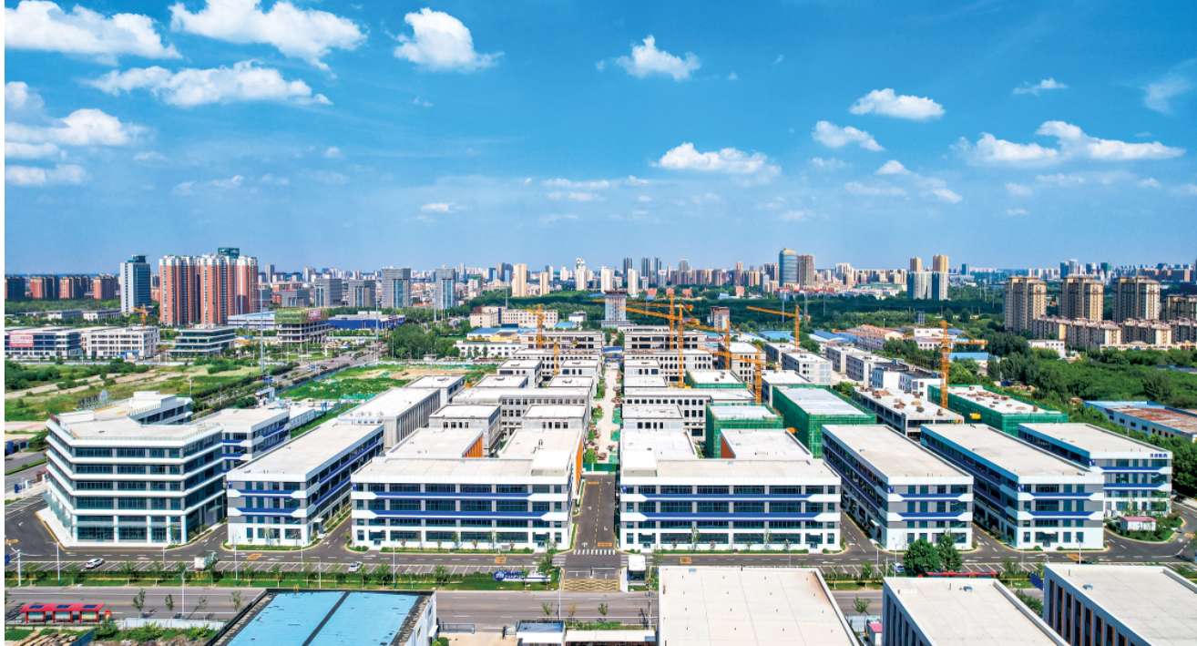
深圳（潍坊）科技工业园施工现场。
