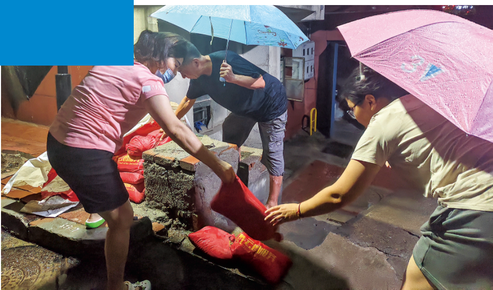
△7月21日晚，奎文区东关街道苇湾社区工作人员在小区铺设防汛沙袋。记者 刘晓杰 摄
