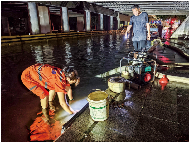
△7月20日晚，在通亭街立交桥下，环卫工人徒手清掏堵塞的雨水算子。 记者 周晓晴 摄
