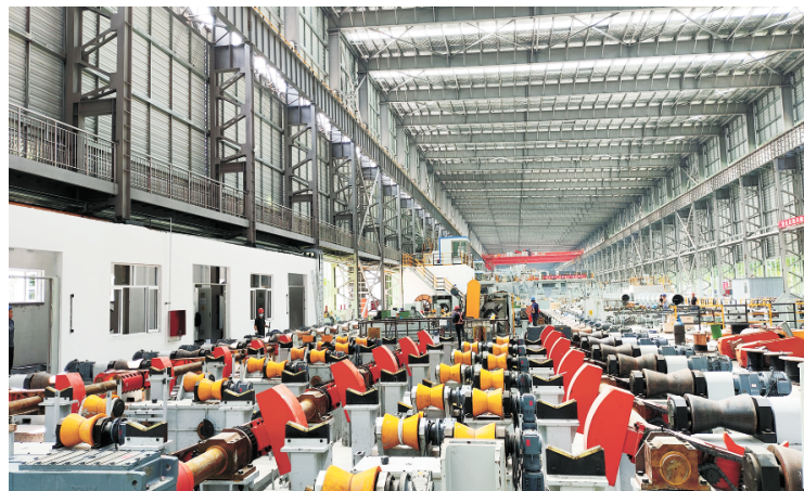
今年以来，寿光牢固树立“项目为王”理念，用好“四个一”调度推进机制，打造闭环管理、完整高效的项目服务保障体系，全力攻大项目、抓好项目，掀起项目建设“硬脊梁”。图为山东磐金钢管制造有限公司高性能无缝钢管项目设备安装现场。
