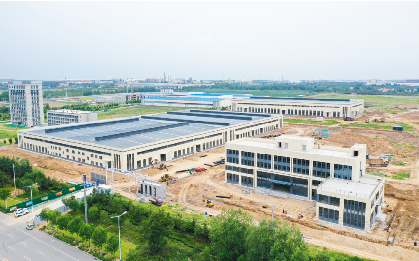
△优博特种高分子改性材料项目建设现场(资料图片)。
