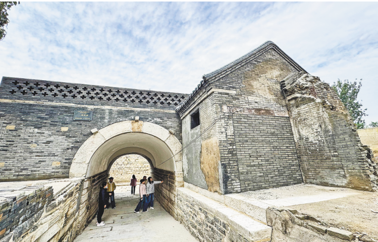
古建绿瓦阁完成修缮 日前,奎文区的潍县东关古城绿瓦阁完成保护修缮工程,吸引了不少市民的目光。工程主要修缮墙体、裂缝、砖檐等,最大限度保留了古建的历史信息。据了解,绿瓦阁又名三元阁,位于潍县东关鱼市街西首,俗称鱼店阁,始建于明代万历三十一年(公元1603年),清代乾隆三十四年(公元1769年)重修。 记者 张驰 摄
