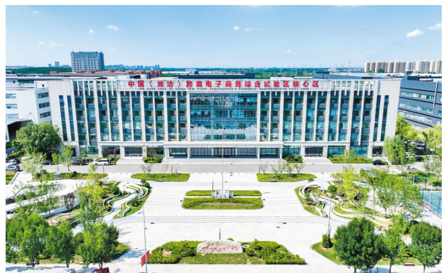
△潍坊跨境电商产业园。通讯员 李煜佳 摄
