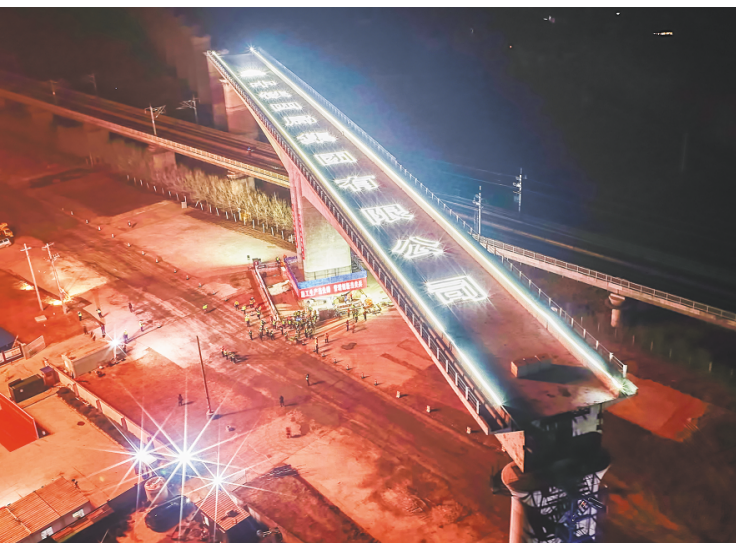
△潍宿高铁潍坊特大桥跨济青高铁连续梁转体施工现场。
