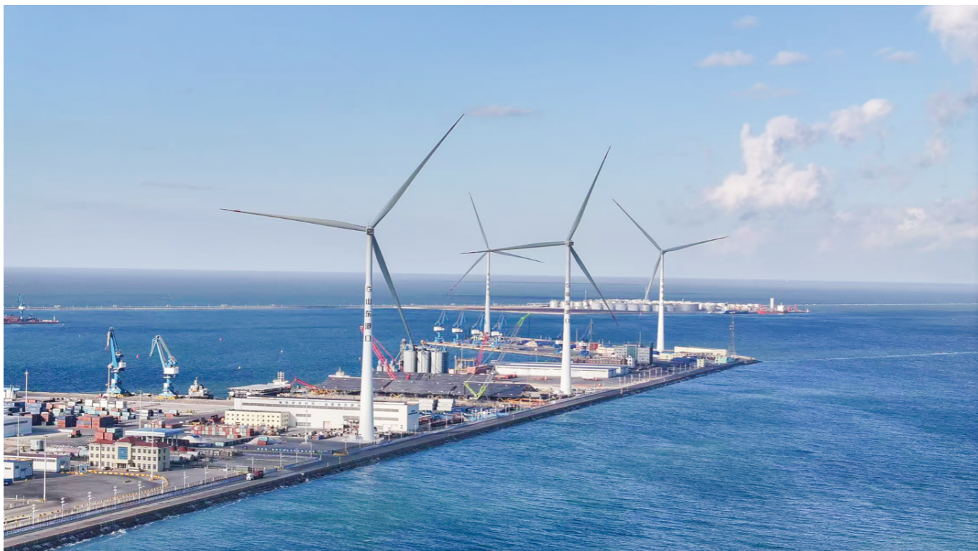
潍坊全域全力推动光伏、风电、生物质能等新能源发展。这是滨海区一处风力发电项目。
