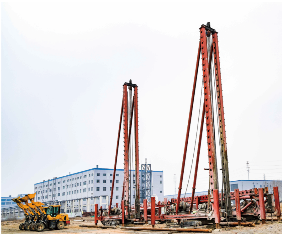
天力药业高端生物制造一体化项目建设现场。
