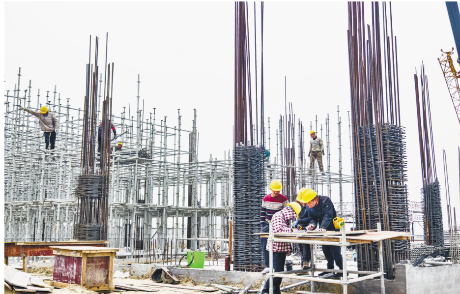
山东安康药业股份有限公司在建厂房。记者 肖雪 摄
