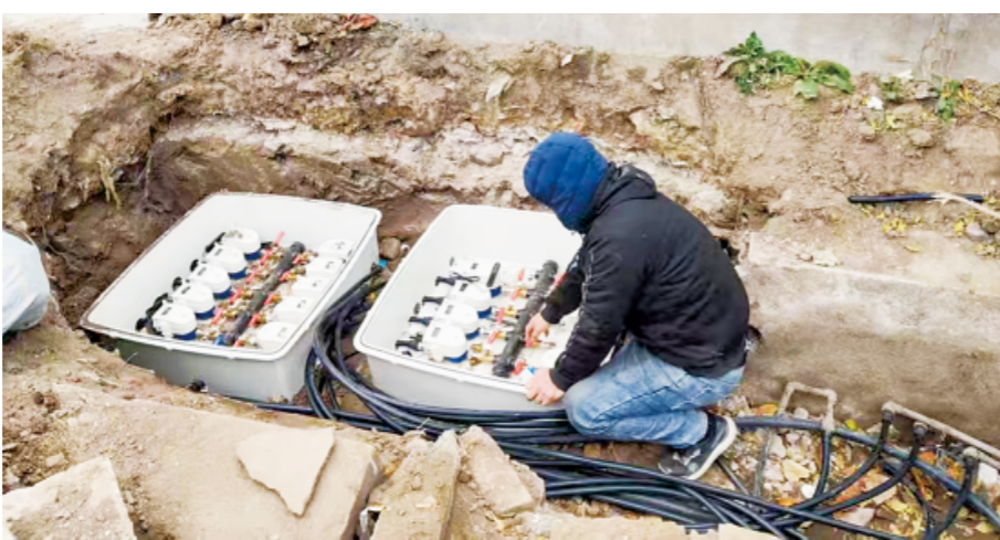
坊安街道东部规模化农村供水工程施工现场。
