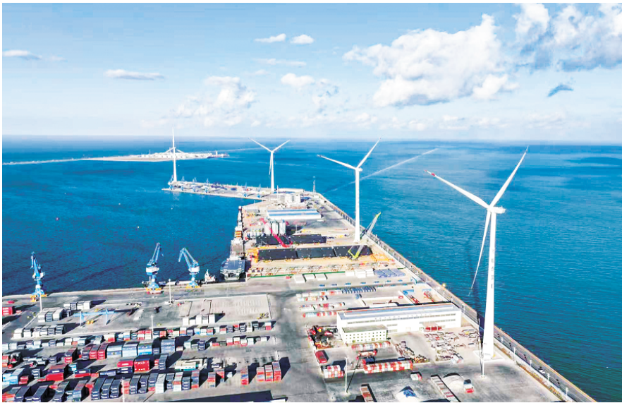
潍坊港东作业区。
